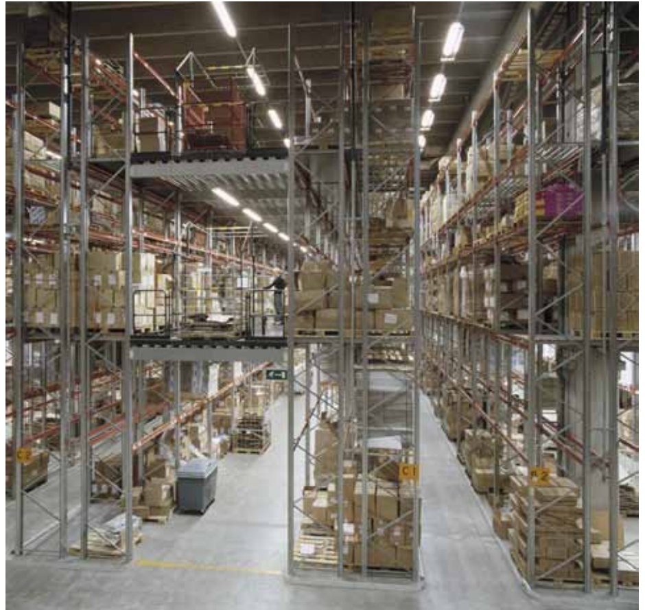
KASTEN K90-kuormalavahyllystä rakennettu kolmikerroshyllystö, jossa keräily tapahtuu läpivirtausradoilta.
